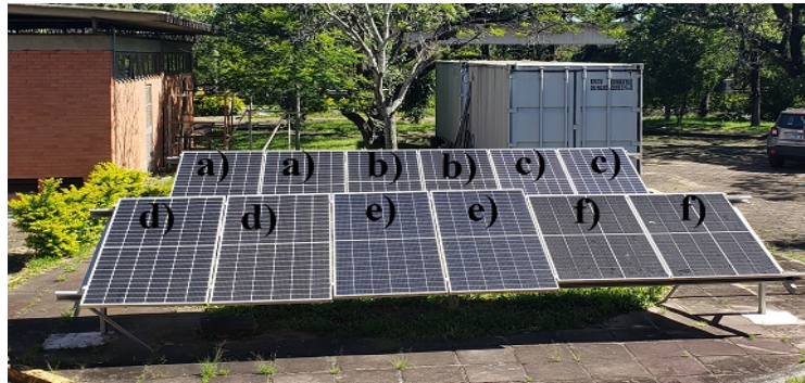
Figura 3 – Vista horizontal do arranjo da micro usina em solo: a) módulo JAM72S30-540/MR; b) módulo JAM72D20-455/MB; c) módulo CS3W-410P; d) módulo RSM144-7-450M; e) módulo ZXM6-NH144-430/M; f) módulo RSM40-8-405M.
