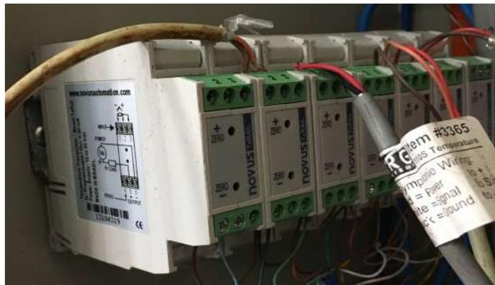
Figura 6 – Transmissores de temperatura NOVUS.
