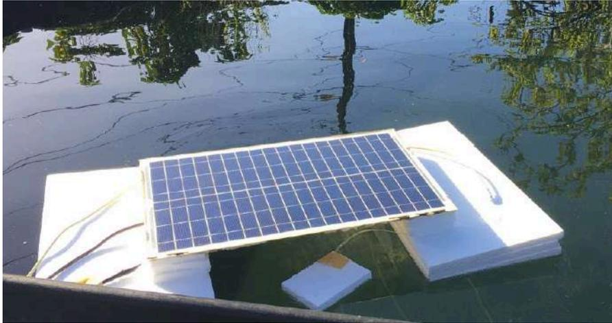
Figura 3- Painel FV instalado sobre a água.
