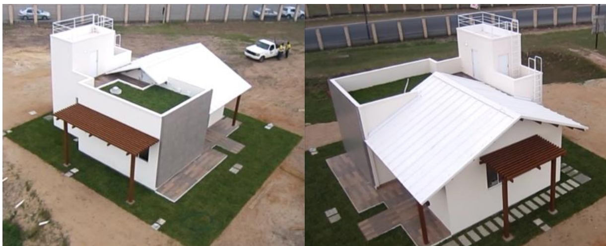
Figura 4- Vista aérea dos telhados vegetado (à esquerda) e com isolamento termoacústico (à direita). Fonte: do autor.
