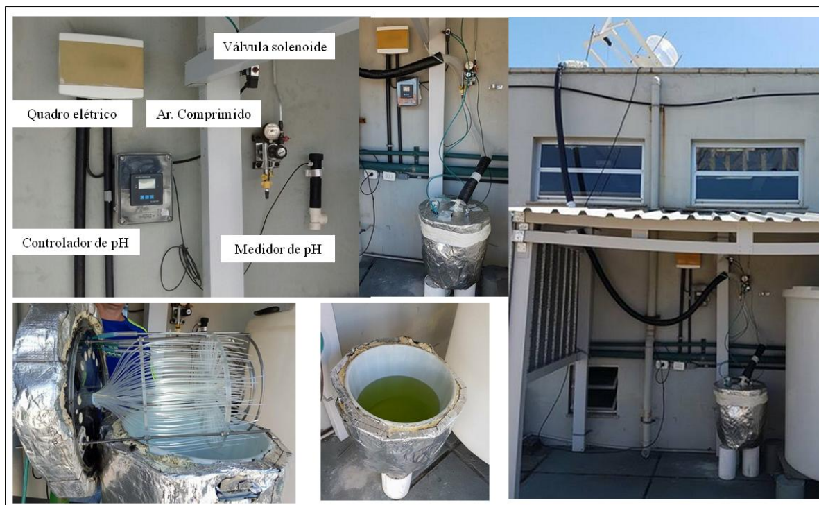
Figura 3- Fotobiorreator não transparente – FNT, com sistema de iluminação por fibras ópticas (POFs) iluminadas por sistema de rastreamento solar.
