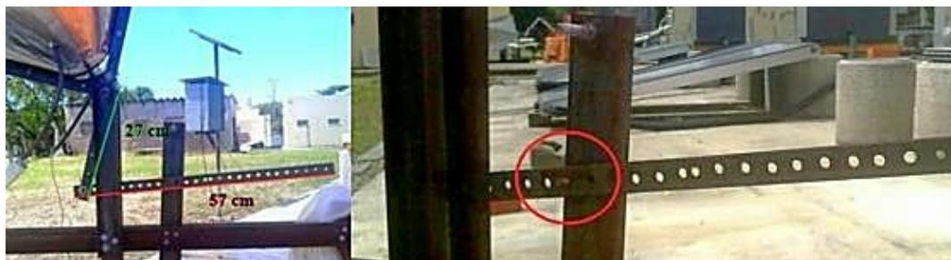
Figura 6 - Base metálica com sistema de ajuste dos ângulos do coletor.
