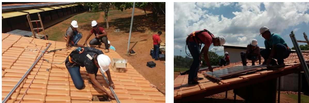
Figura 11 - Montagem das estruturas e instalações dos módulos fotovoltaicos.
