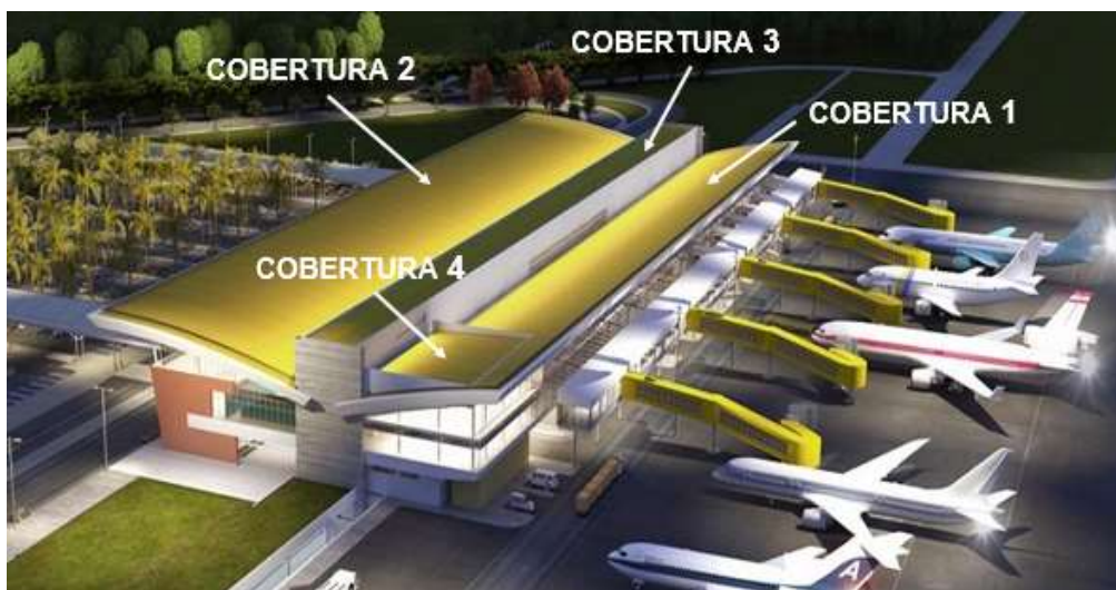
Figura 4 - Identificação das coberturas 01 a 04 - TPS Fonte: Imagem fornecida pela INFRAERO (adaptada pelos autores).
