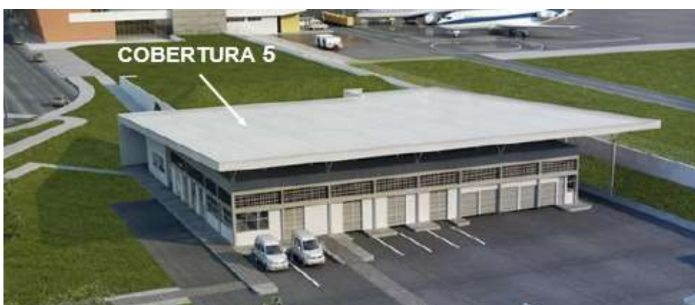
Figura 5 - Identificação da cobertura 05 - CUT Fonte: Imagem fornecida pela INFRAERO (adaptada pelos autores).
