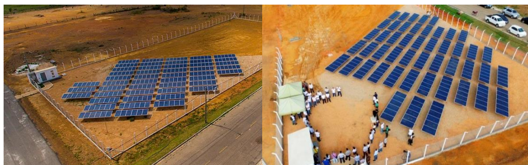
Figura 7 - Foto aérea da usina solar fotovoltaica da COOBER (COOBER, 2017).
