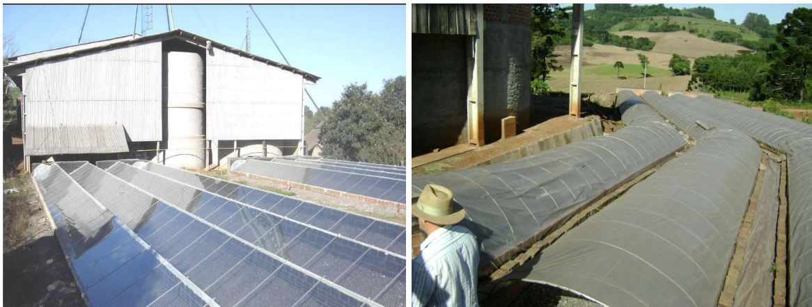
Figuras 6 e 7: coletores solares no município de Casca, com brita e fechamento de (6) vidro e (7) plástico Fonte: Rafael Gomes Dionello.
