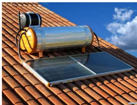
Figura 5: modelo de coletor solar com 2 m 2 e reservatório térmico com capacidade de 200 L.
