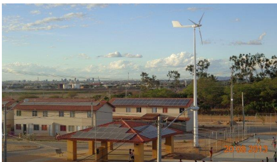
Figura 2 - Aerogerador e painéis fotovoltaicos instalados nas residências dos condomínios.
