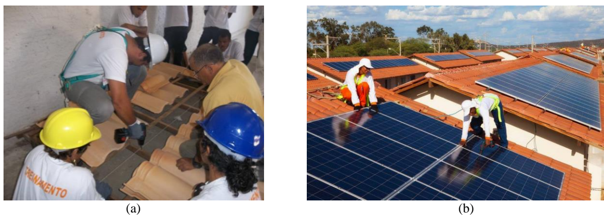
Figura 6 - (a) Equipe em treinamento; (b) Instalação dos painéis fotovoltaicos.
