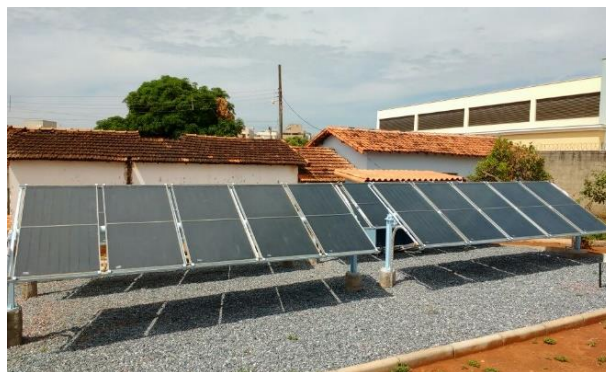
Figura 3 – Coletores solares térmicos – Vila Vicentina – Sete Lagoas/MG
