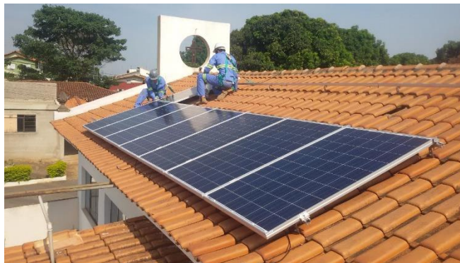
Figura 4 - Instalações dos módulos fotovoltaicos no telhado da igreja - Vila Vicentina - Sete Lagoas/MG
