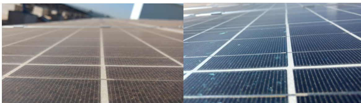
Figura 7 - Comparação dos módulos fotovoltaicos antes da limpeza e depois da limpeza
