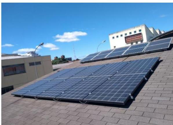
Figura 1 - Sistemas fotovoltaicos instalados no Escritório Verde.
