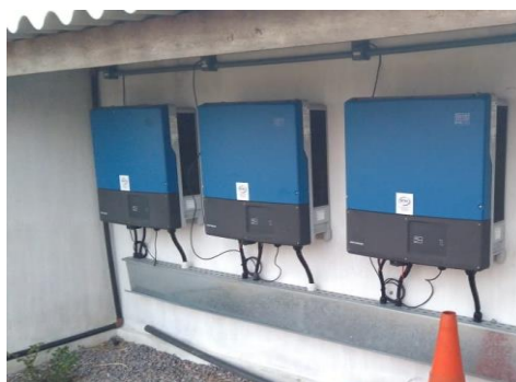
Figura 2 – Inversores Sunny Tripower da usina solar da UFERSA Campus Caraúbas.
