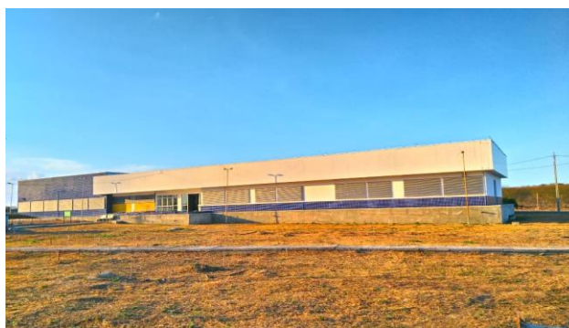
Figura 4 – Fachada principal do bloco de salas de aula dois (2) da UFERSA Campus Caraúbas.
