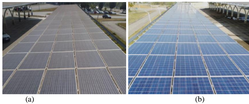
Figura 19 - (a) Seção com acúmulo de partículas de solo, poluição e dejetos de pássaros, (b) Seção após lavagem
