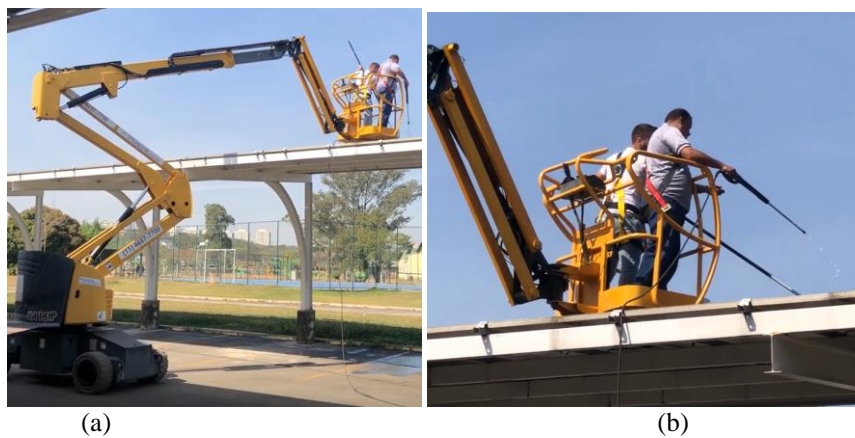
Figura 18 - (a) Braço estendido da plataforma elevatória para acesso aos módulos distantes, (b) Colaboradores para limpeza com o esfregão, lavagem com a lavadora de alta pressão e operação da plataforma.
