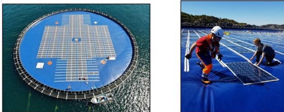
Figura 4 – Plataforma FVF - Membrana. Fonte: Ocean Sun (2019)
