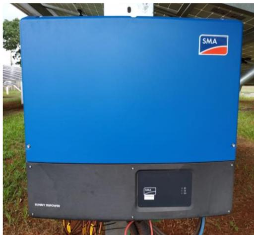
Figura 4: Inversor utilizado na conexão dos módulos monocristalinos
