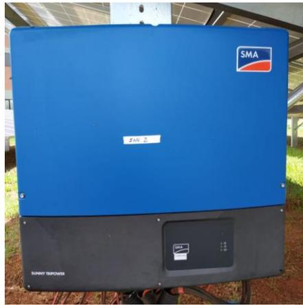
Figura 2: Inversor utilizado na conexão dos módulos policristalinos
