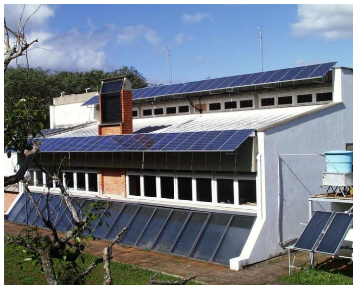
Figura 1- Foto da fachada norte do prédio do LABSOL onde estão instalados os módulos que compõem o arranjo avaliado neste trabalho.
