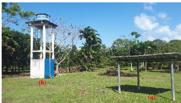
Figura 1 - (a) gerador fotovoltaico instalado na localidade e (b) estrutura montada para o reservatório de água.
