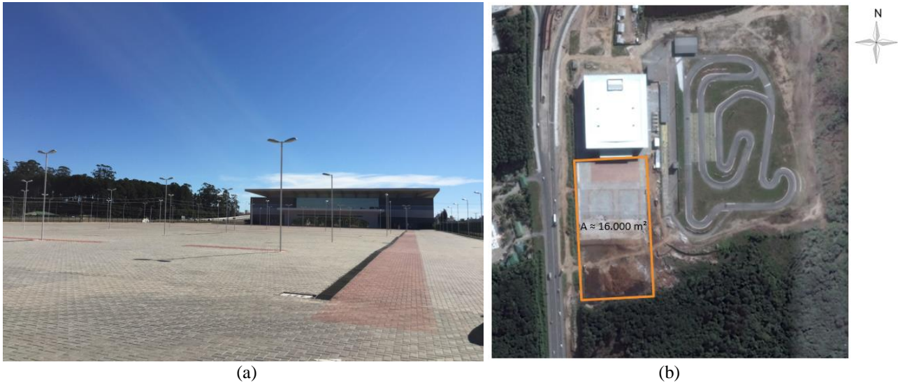
Figura 1 (a) Foto do estacionamento localizado em frente ao Centro de Eventos e (b) Imagem aérea com destaque para área disponível para implantação do estacionamento FV.
