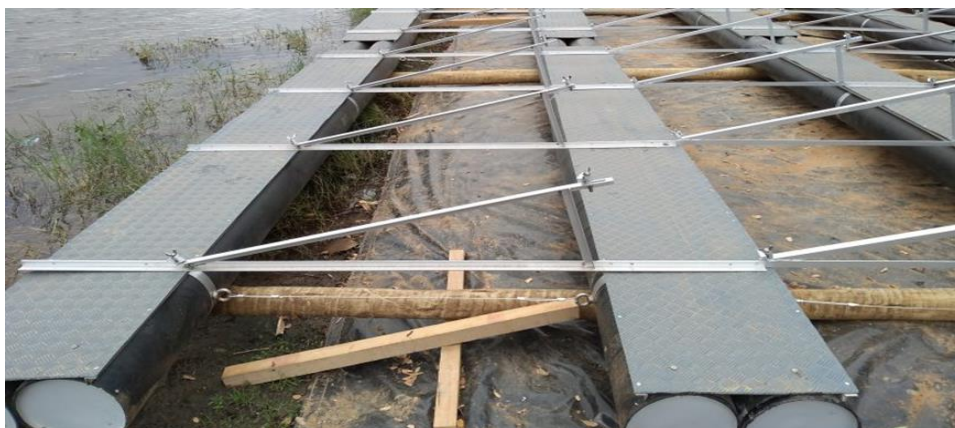
Figura 5 – Montagem dos suportes em alumínio nos flutuadores de PEAD.
