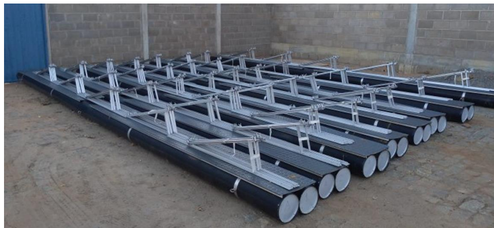
Figura 4 – Pré-montagem da estrutura flutuante nacional.
