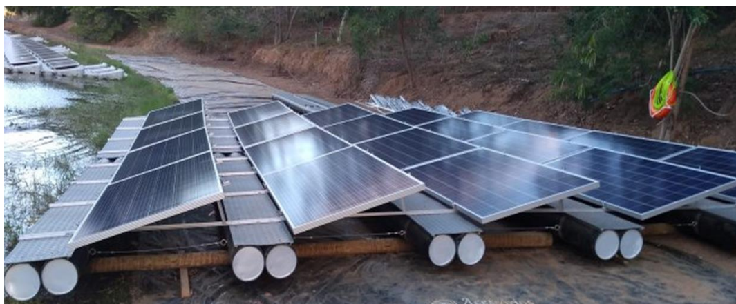
Figura 6 – Montagem final de um bloco com 20 módulos.
