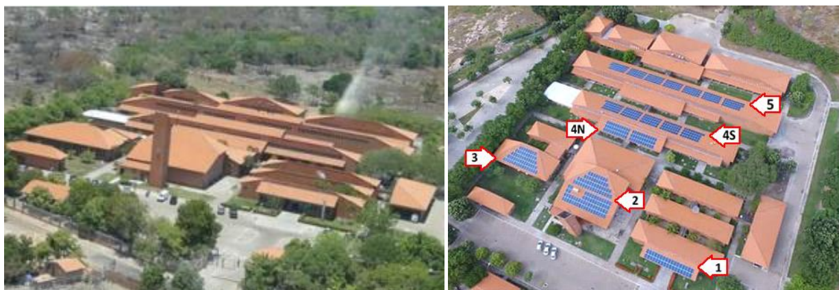
Figura 2 – Imagem aérea do SFCR do campus Florianópolis do IFPI e disposição dos módulos fotovoltaicos.
