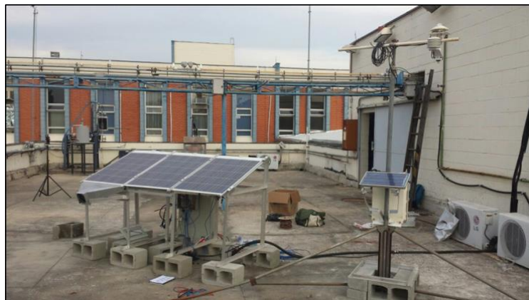
Figura 6- Módulos com dissipadores e estação solarimétrica.
