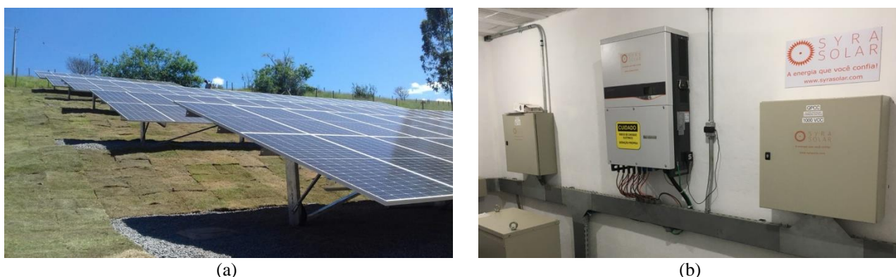
Figura 3 – Fotos (a) dos módulos e (b) do inversor selecionados, após a execução.
