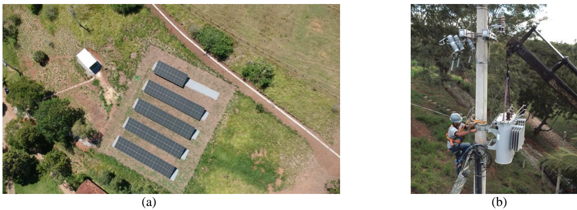
Figura 7 – Fotos (a) da usina fotovoltaica e (b) da troca do transformador.
