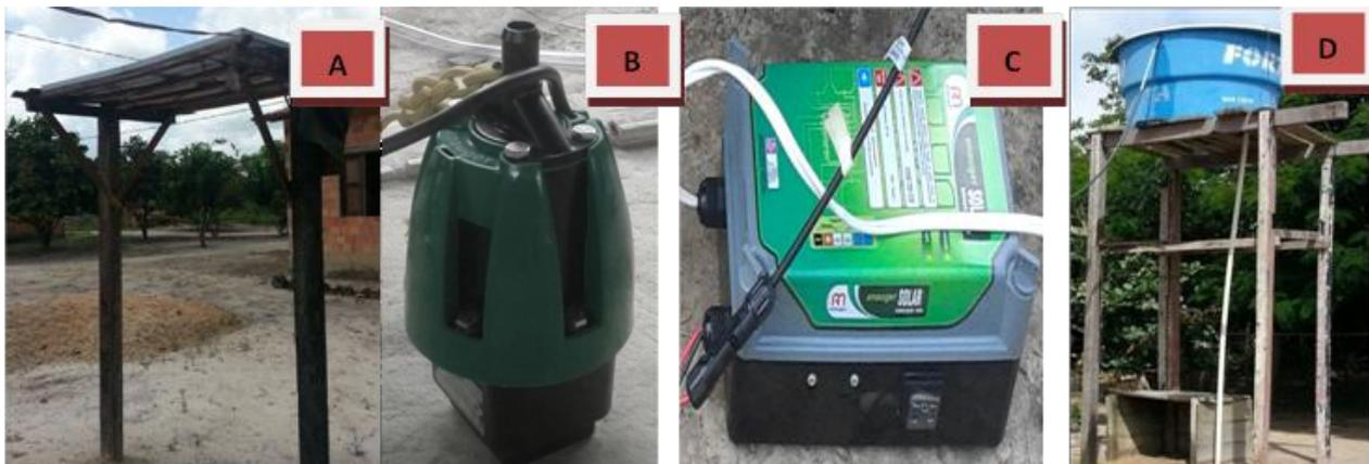
Figura 2 – (A) Painéis fotovoltaicos; (B) Bomba d'água vibratória; (C) Driver; (D) Caixa d'água.
